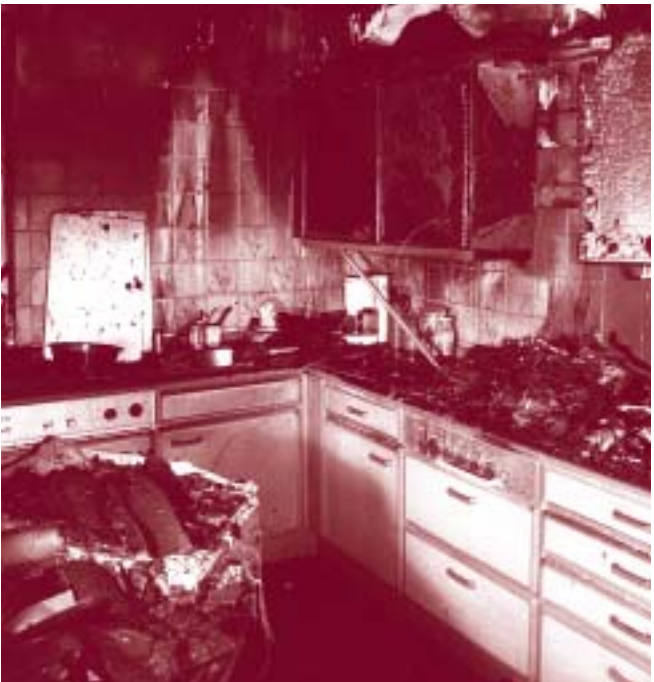
Ein Albtraum: die Küche ist völlig ausgebrannt.
